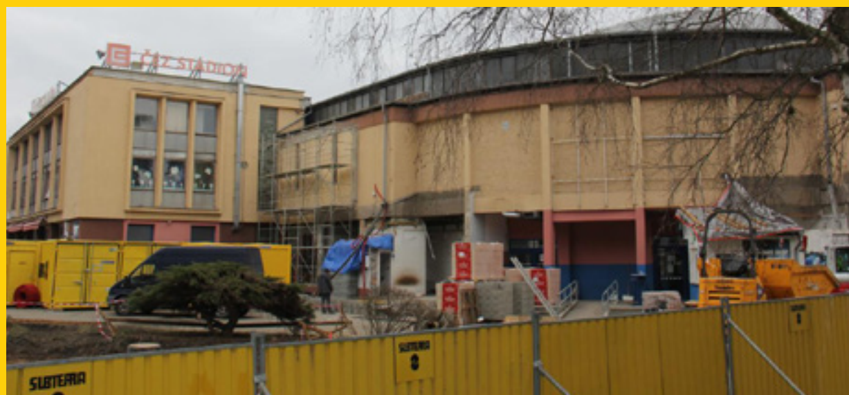
Probíhající rekonstrukce ČEZ stadionu Kladno / foto: Rytíři Kladno.
